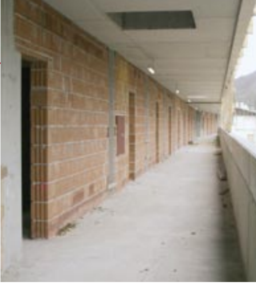
Gemischt: Wo von den Statikern kein Beton verlangt wird, wird mit Ziegel gebaut
