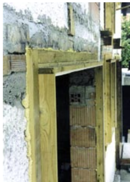
Abb 13 | Vorstehender Blindstock (Fensterahmen) zur optischen Reduktion der Dämmstärke.
