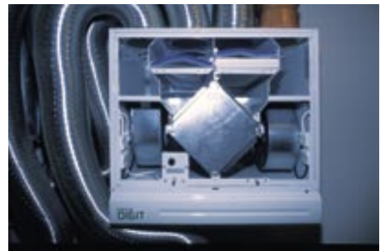
Abb 58 | Lüftungsgerät mit Wärmetauscher
