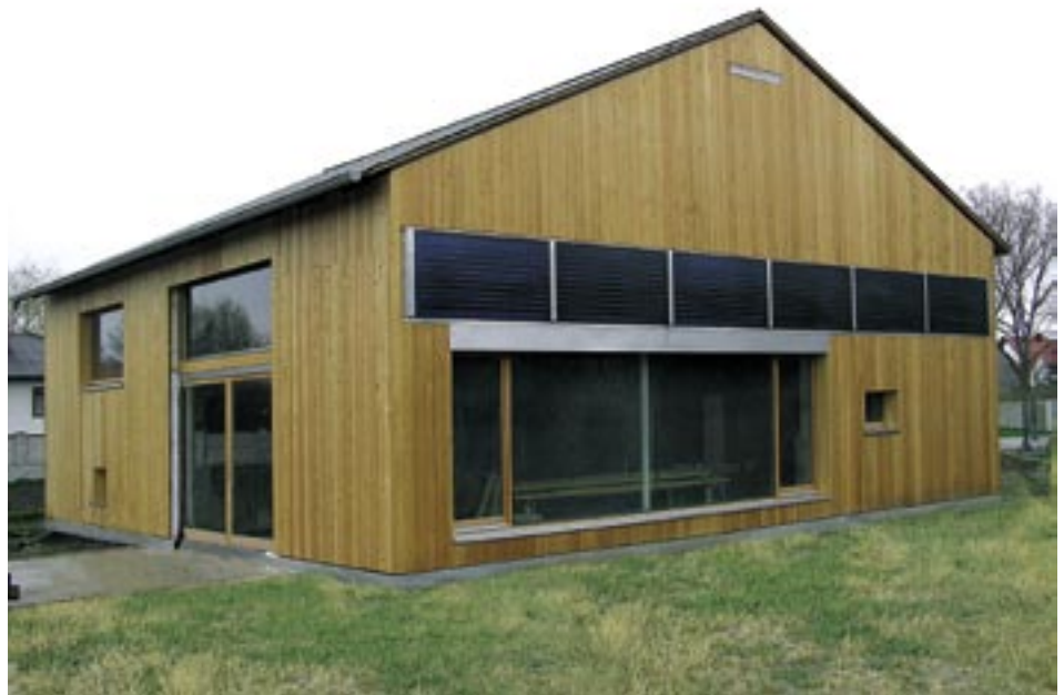
Abb 18 – 19 | Mit der Sanierung des ehemaligen Wirtschaftsgebäudes wurde 2003 begonnen. Die 12 m 2 große Kollektorfläche für die Warmwasserbereitung wurde in die Südfassade integriert.
