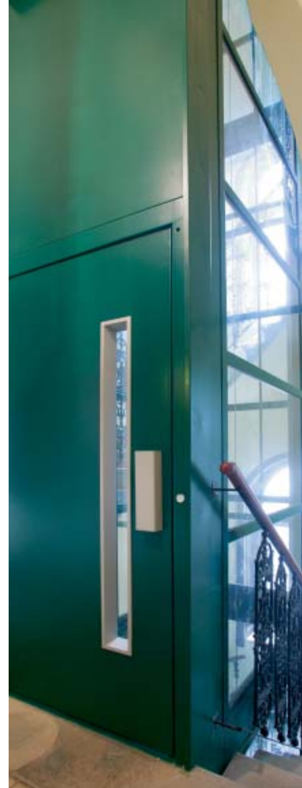
Ersatz der Treppe durch Aufzug; neue Treppe außerhalb des Gebäudes
